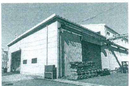
増床中の本社倉庫
