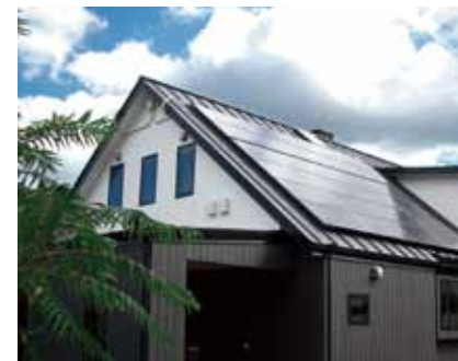
金属屋根にHIT(ハイブリッド型)パネルを9.78kW設置した新築住宅
