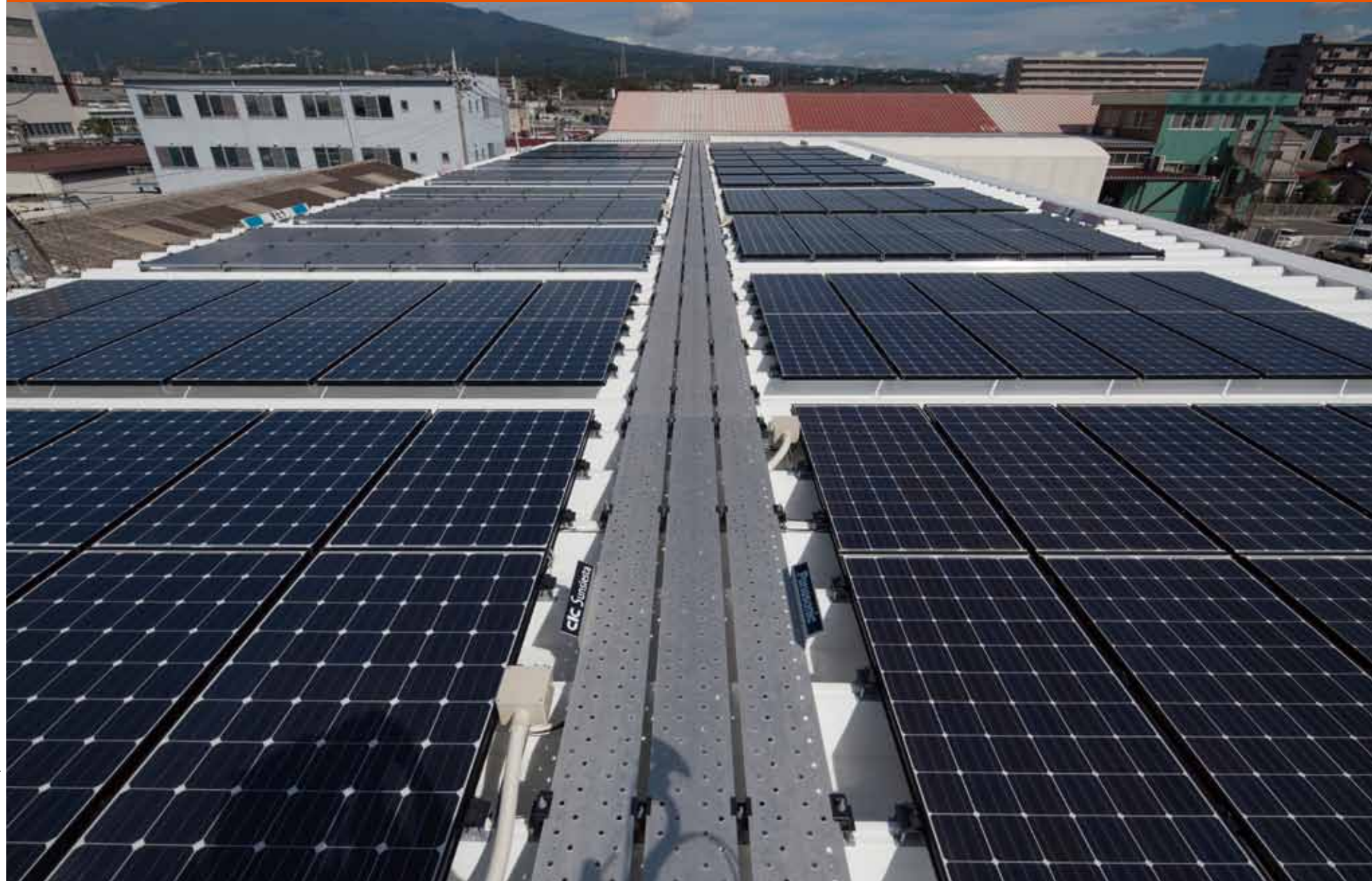
展示場(本社工場)の屋根に主要メーカー7社のパネルを同条件、同容量で設置している
